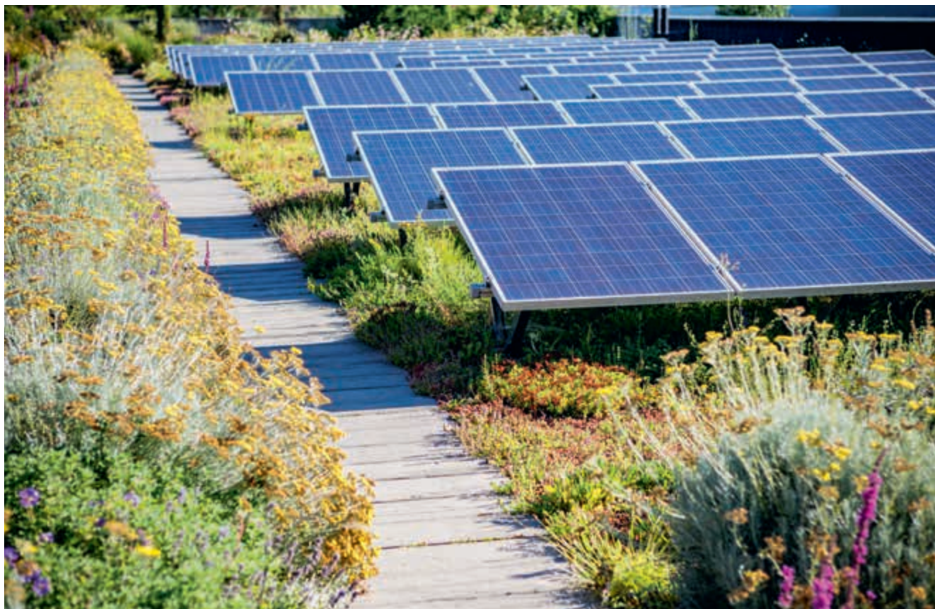
Abbildung 3: Kombination Intensiv-/Extensiv-Dachbegrünung neben PV-Anlage, Quelle: Contec
