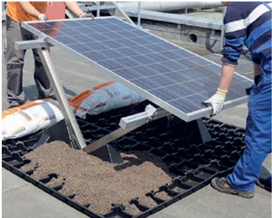
Abbildung 6: Auflastsystem für PV-Aufständerung, Quelle: Bauder
