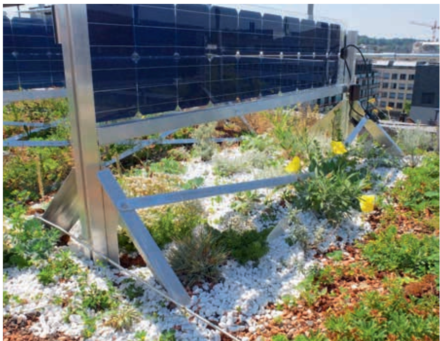
Abbildung 7: PV-Anlage mit bifazialen Modulen auf dem Dach der Seniorenresidenz Eichgut, Winterthur. Ein heller Untergrund mit silbrig-laubigen Pflanzen – wie Sonnenröschen und Thymian – begünstigt die Reflexion des Sonnenlichts und führt zu einem Mehrertrag in der Solarstromproduktion. Quelle: Solarspar
