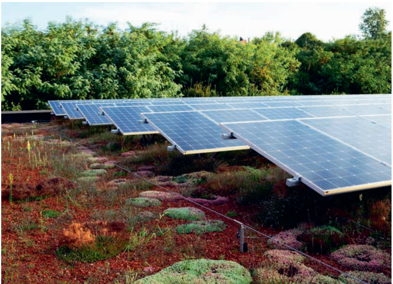
Abbildung 1: PV-Anlage kombiniert mit Extensivbegrünung, Quelle: contec
